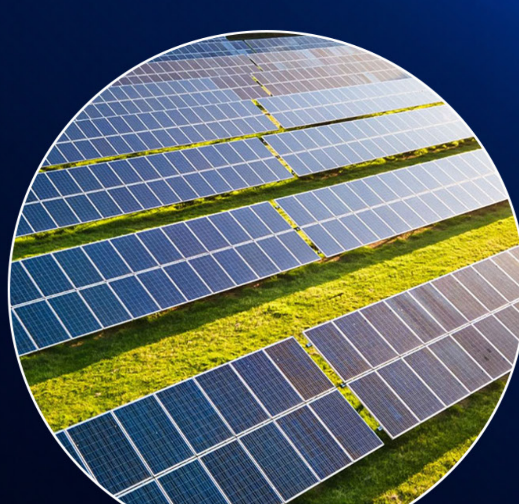
Güneş Panelleri Solar Panels
